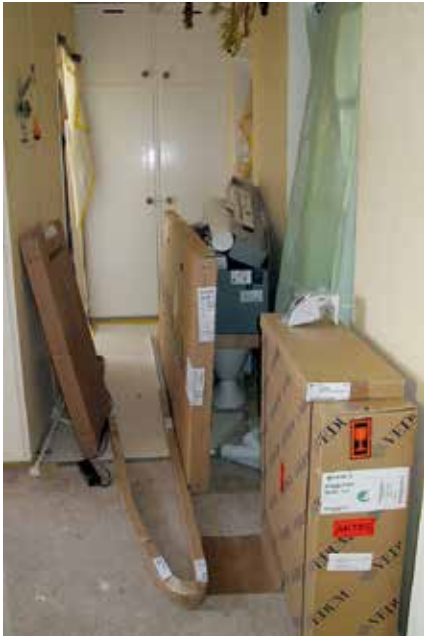
Kaos i hallen – nu har arbetet satt igång på allvar.
