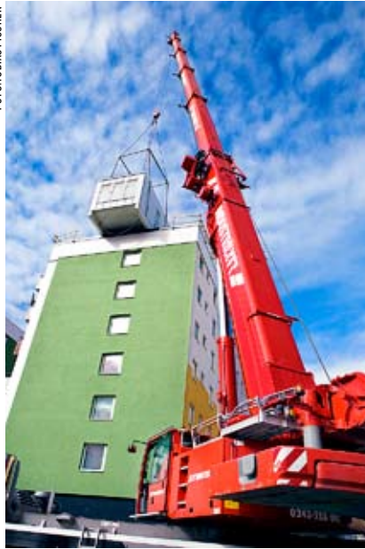
Etagelägenheternas takvåning lyfts på plats med lyftkran.
